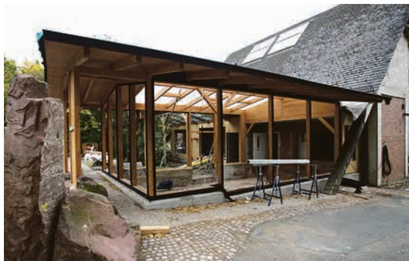
Am Giraffenhaus entsteht eine neue Unterkunft für die Totenkopffaffen.
