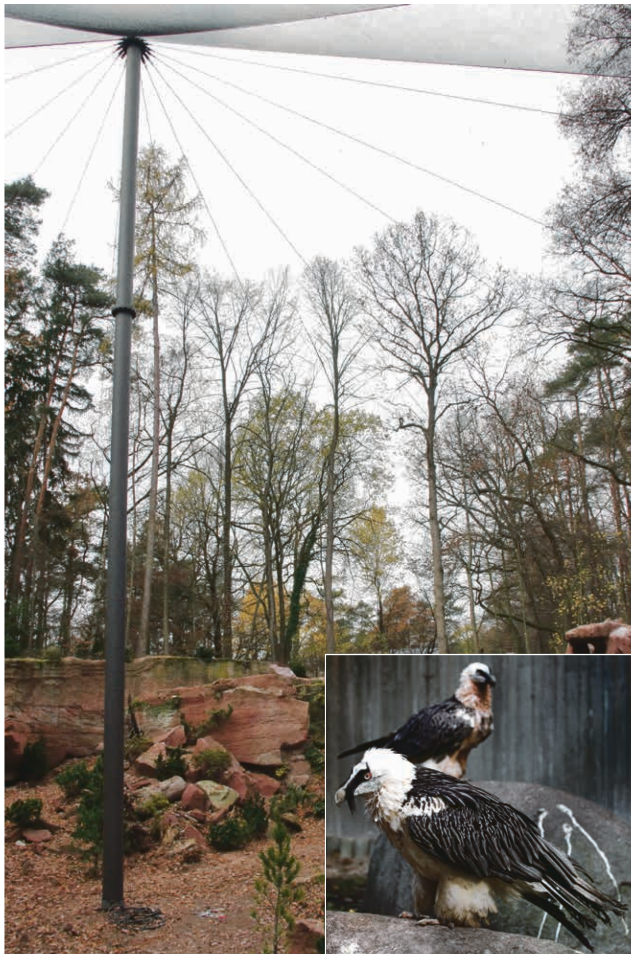
Im alten Braunbärgehege wurde der 18 Meter hohe Mast für die Voliere der Bartgeier (kleines Bild) gesetzt.
